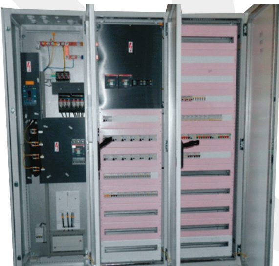
Vývodové polia z hlavného roz. RH 2500A pre drevovýrobu.
