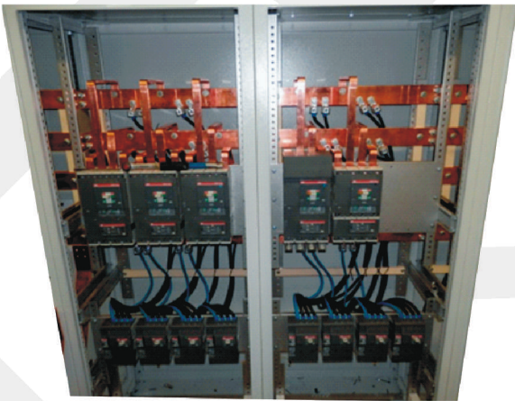
Vývodové polia z hlavného roz. RH 2500A pre drevovýrobu.
